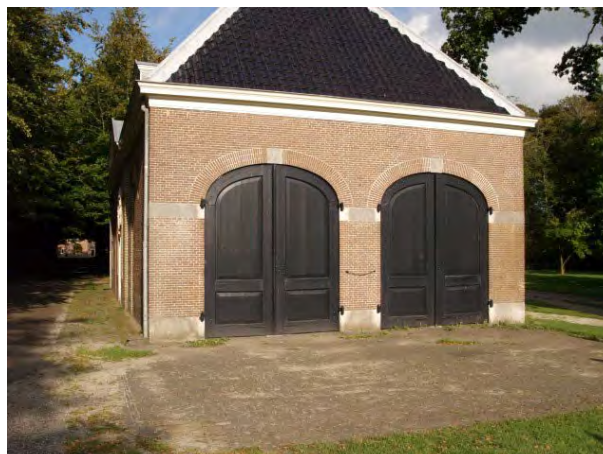
Kleine onregelmatigheden door zettingen in oude verharding dragen bij aan het gevoel van authenticiteit; reparatie is alleen nodig als dat voor de instandhouding en het gebruik noodzakelijk is.
