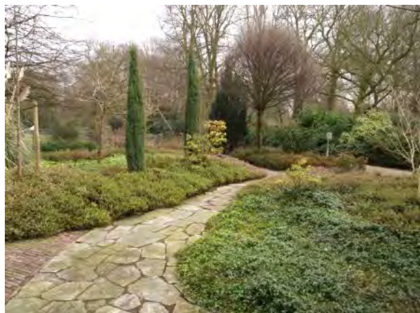
Een flagstonepad in een stadspark. De flagstone tegels zijn met cement gevoegd. Hierdoor komt er geen onkruidgroei op voor. Het pad watert naar de zijkanten af.
