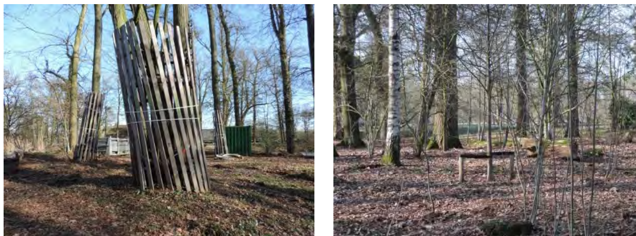
Bij het werk in dit parkbos wordt schade aan de stammen voorkomen maar is de wortelzone ook voldoende beschermd?
